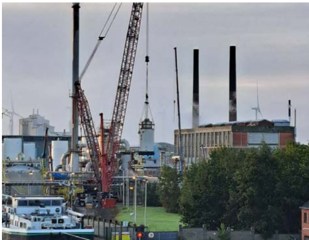
Afbeelding: droogtoren installeren tijdens stopzetting zwavelzuur
