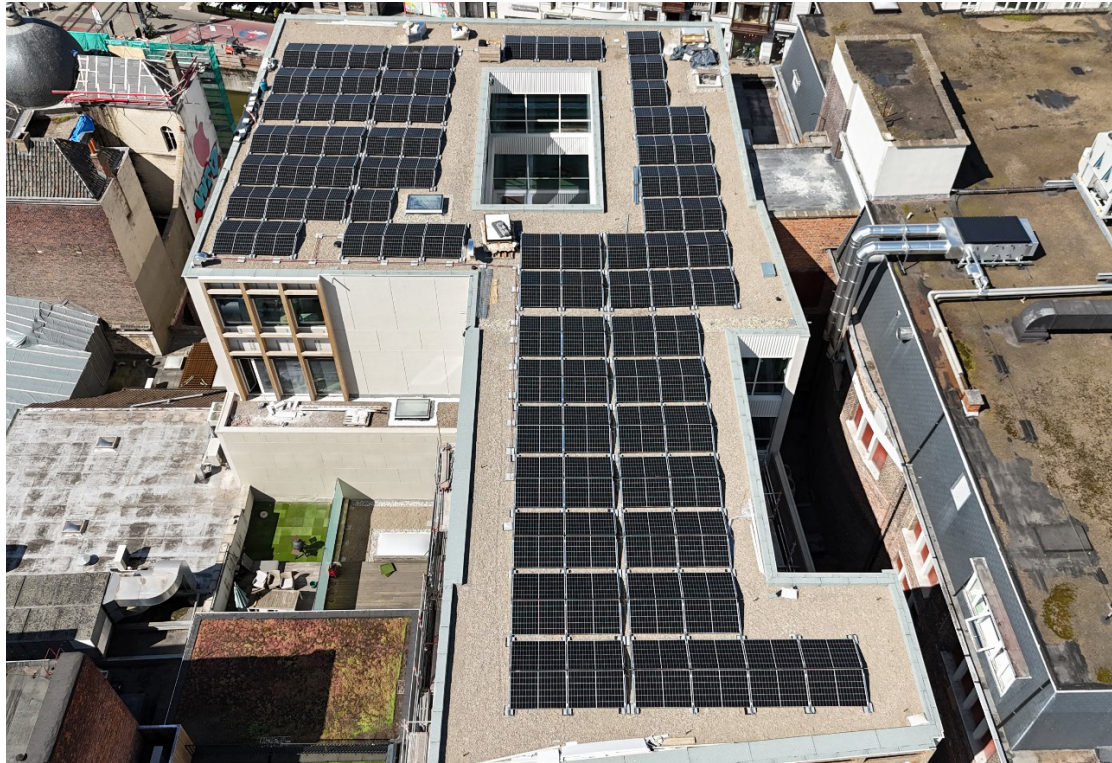
De zonnepanelen op het pand Veldstraat 88, Gent:
