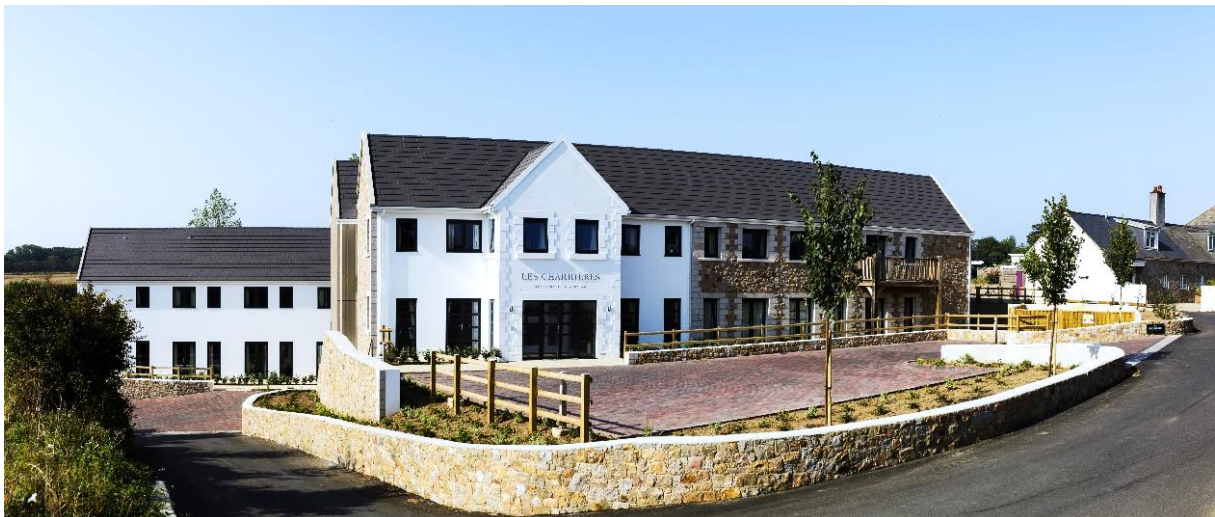
Les Charrières in Jersey
